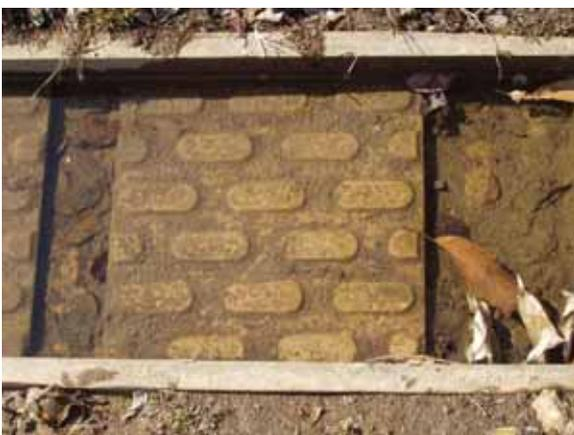
図5 敷設した光触媒タイル
