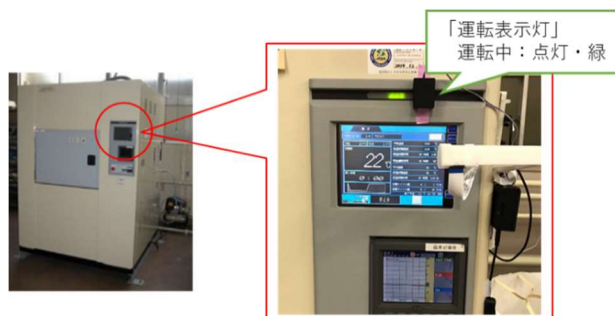
図 1 計装パネル周辺写真
