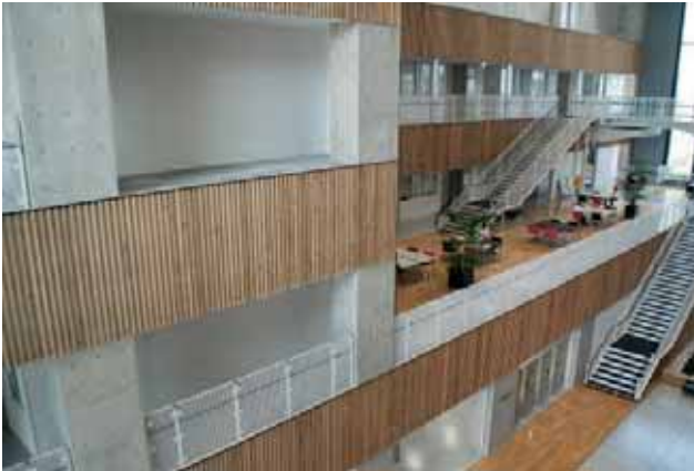
あいち産業科学技術総合センター内の 難燃処理が施された木製ルーバー
