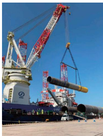
繊維スリングを用いた洋上風力発電施工風景
