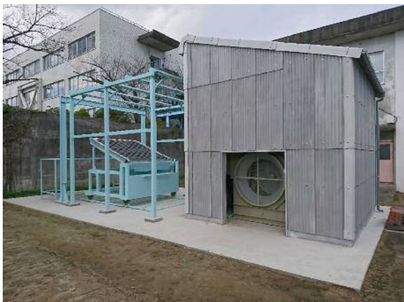
送風散水試験用設備
