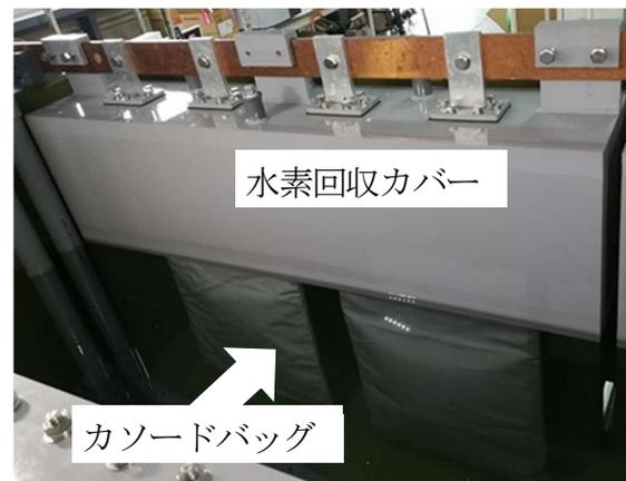
図3 カソードバッグと水素回収カバーによる副生水素回収設備
