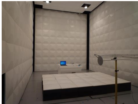
あいち産業科学技術総合センター に整備された電波暗室
