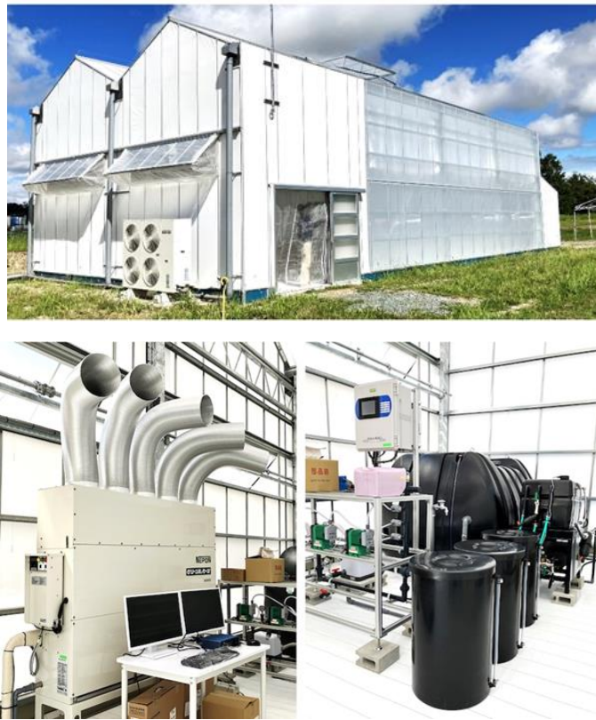
図1 セミクローズド温室の外観(上)と内観(制御室)(下)
