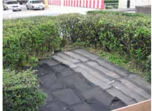
図5 中央分離帯へのエンボスマット敷設
