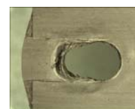
図 8 ボルト接合部
