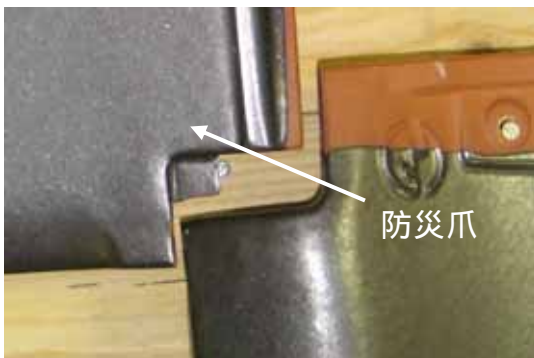
写真1 和形防災瓦の防災形状
