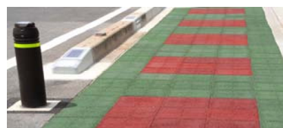
図2 国道の歩道への敷設状態
