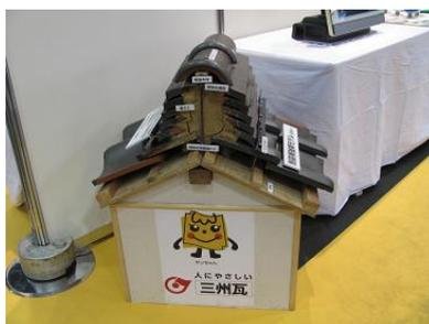
住宅棟瓦の耐震補強工法の模型
